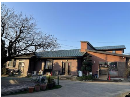
園庭から見た園舎
