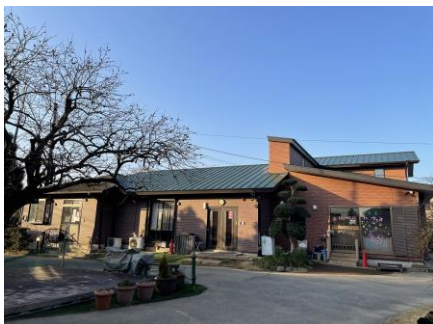
園庭から見た園舎
